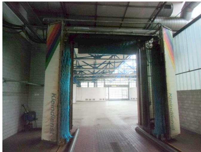
Fahrzeugwaschanlage Schwarze Pumpe
