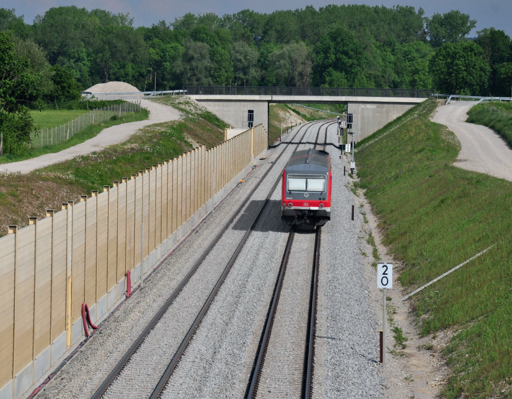
Die Züge der Traun-Alz-Bahn nutzen zwischen Mühldorf und Garching an der Alz die Trasse der ABS 38. Hinter Garching sind weitere Ausbau- und Beschleunigungsmaßnahmen notwendig.
