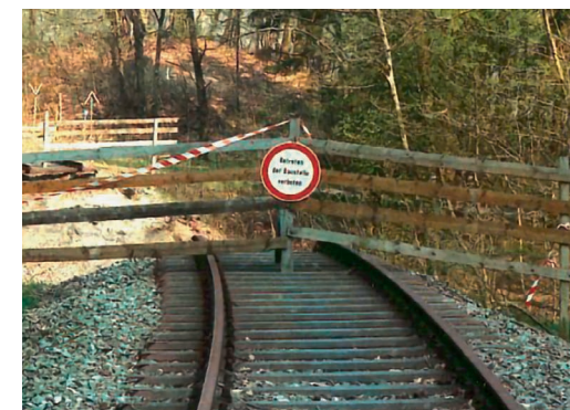
Die Wasserburger Altstadtbahn ist seit 1987 durch einen Dammrutsch unterbrochen.
