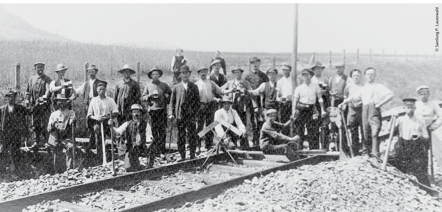
Bauarbeiten auf dem ersten Streckenabschnitt Bleicherode – Kleinbodungen 1907
