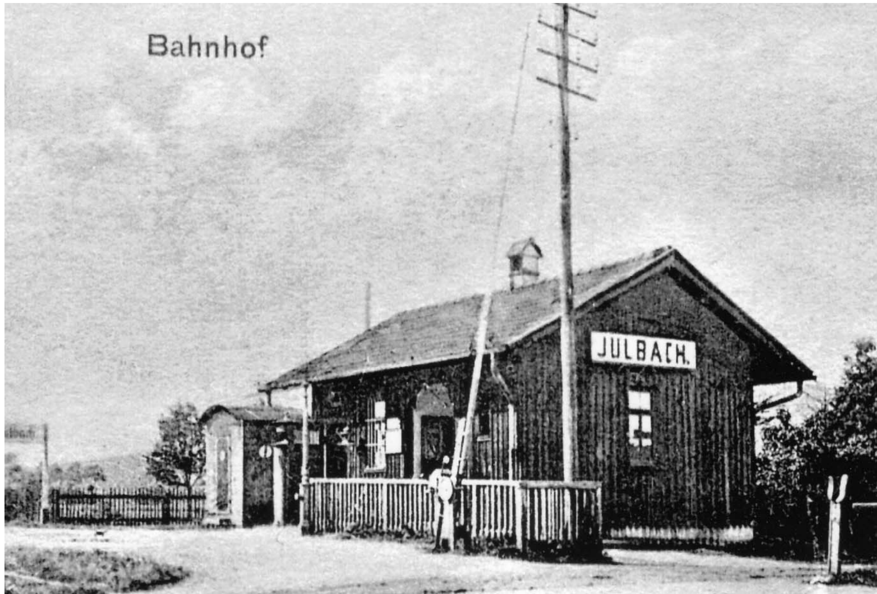
Das Betriebsgebäude der 1907 eröffneten Haltestelle Julbach ähnelte den typischen Agenturgebäuden, wie sie sehr zahlreich auf den bayerischen Lokalbahnen errichtet wurden. Ausschnitt aus einer Ansichtskarte von 1929, Sammlg. Alfred Baumgartner
