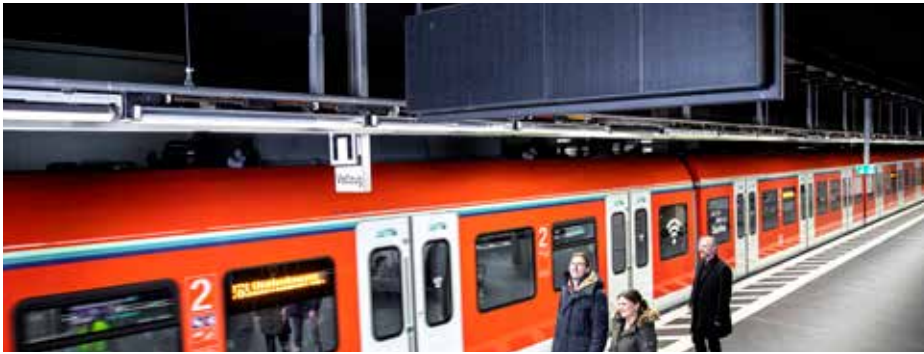
Holoplot-Module über den Bahnsteigen: Die Anlage durchläuft einen sechsmonatigen Test im Frankfurter Tiefbahnhof.
