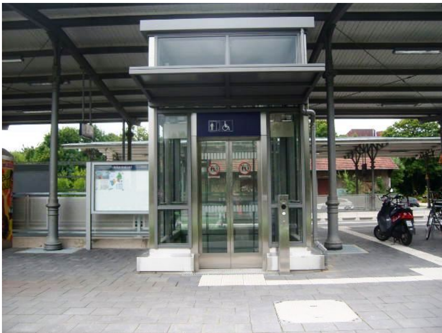
Abb. 4: Aufzug in Seesen (Quelle: DB Station&Service AG)
