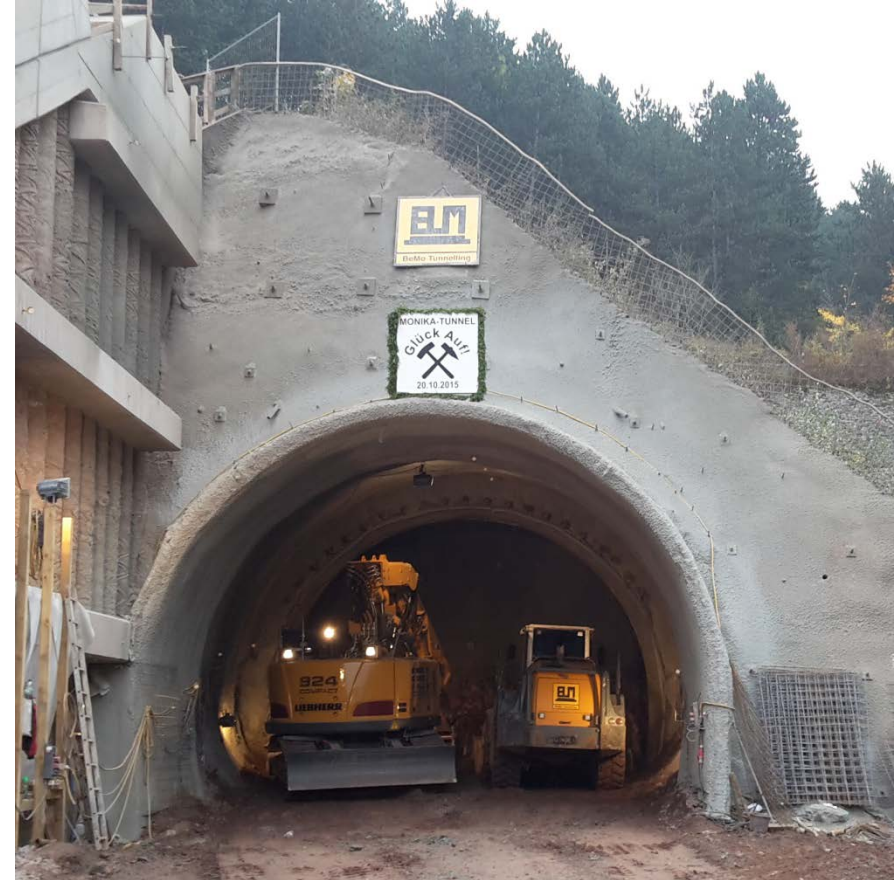
Tunnelbagger und Pneulader nebeneinander im Zierenberger Tunnel
