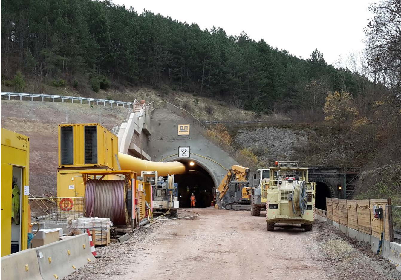
Westportal des Zierenberger Tunnel
