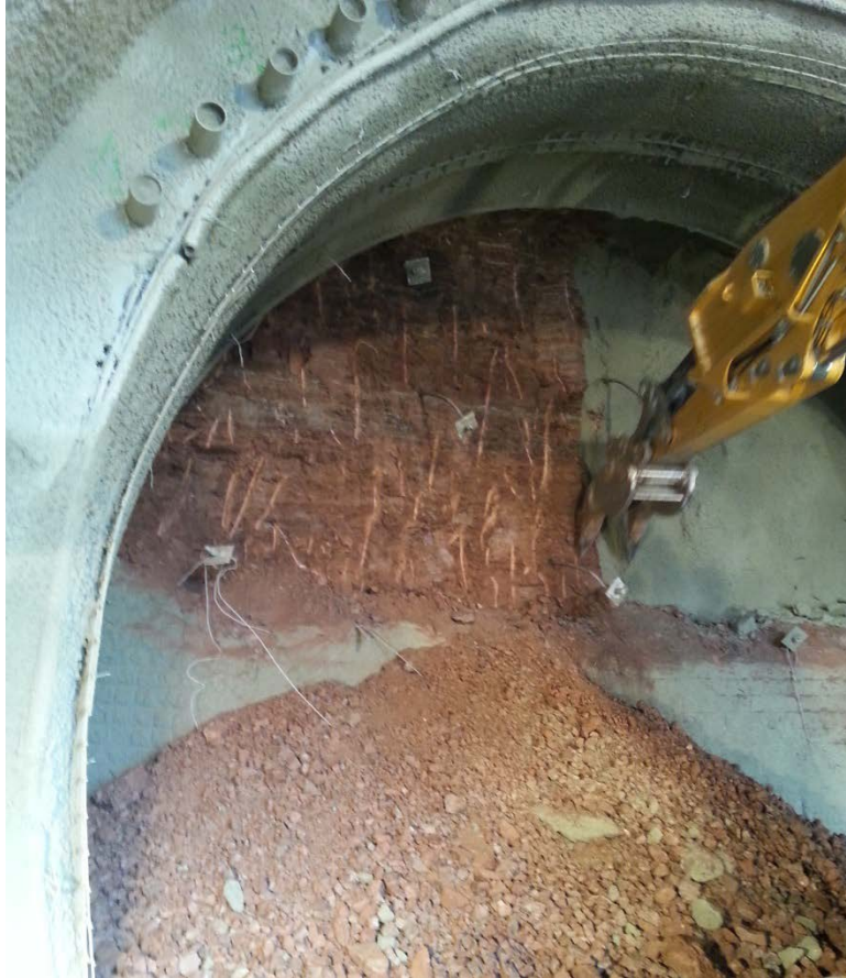
Lösen des Gebirges im oberen Bereich des Tunnels, der sogenannten Kalotte
