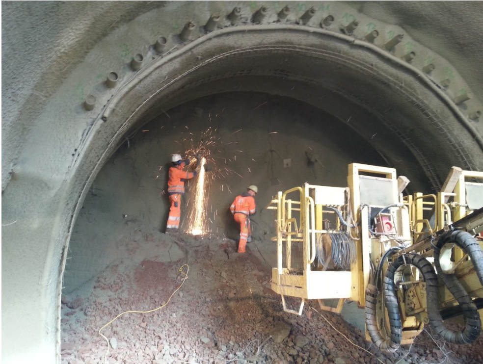
Einbau der Ortsbrustanker als Sicherungsmaßnahme
