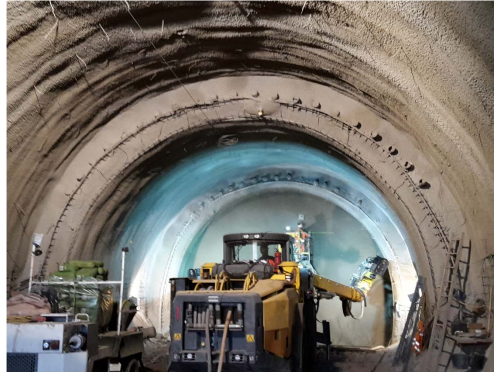
Einbau der Sicherungsmaßnahmen mit einer Hebebühne
