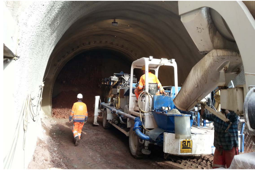
Befüllen des Spritzmobils mit Beton
