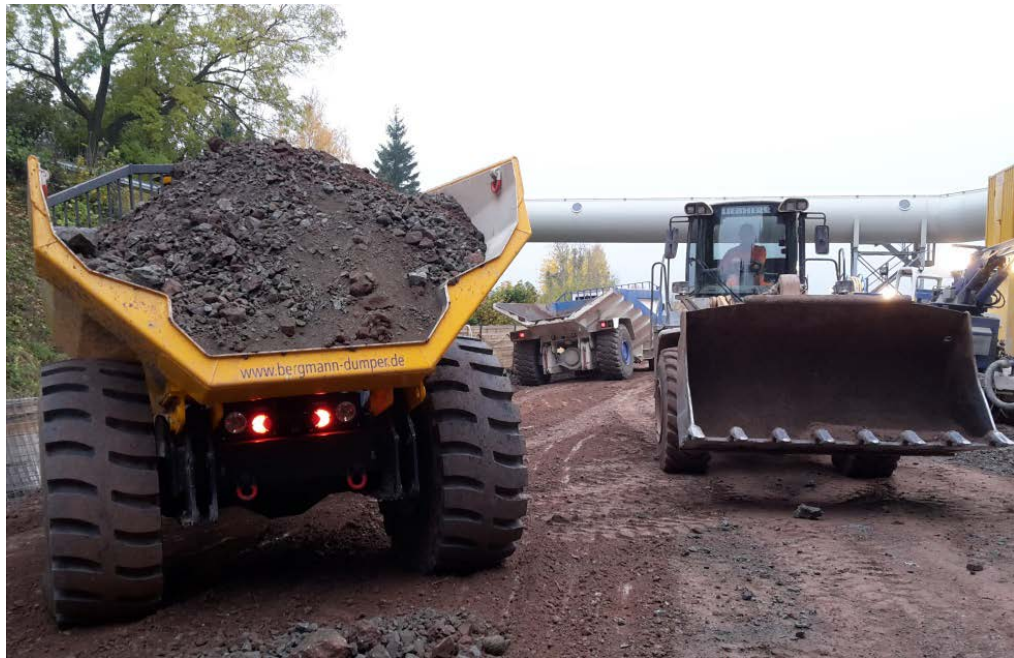
Beladen des Muldenkippers mit Ausbruchsmaterial
