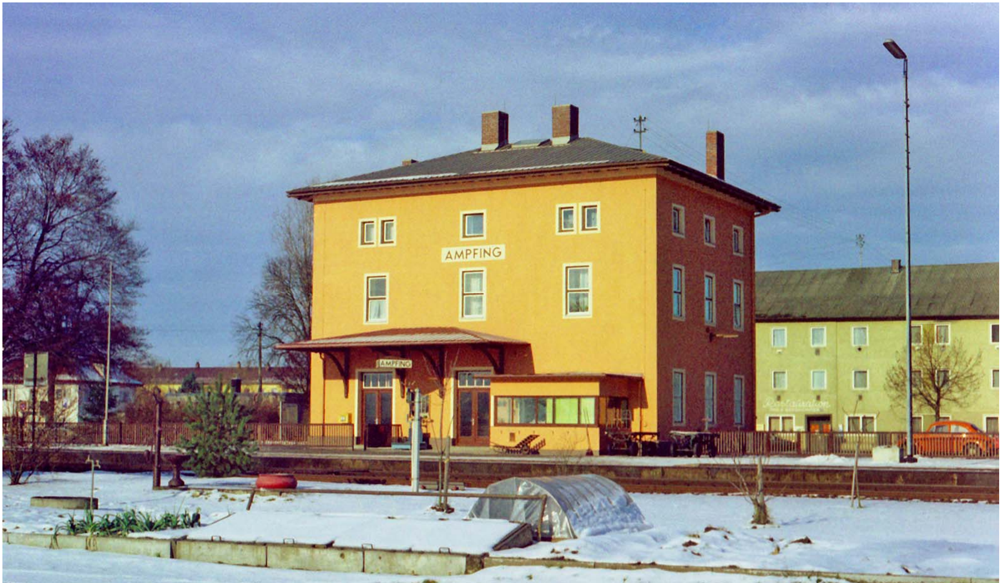
Mit vier Betriebsgleisen und niedrigen Bahnsteigen präsentiert sich der Bahnhof Ampfing am 25. Dezember 1978 in der Wintersonne. Seit 2010 kontrastieren hohe Lärmschutzwände mit dem historischen Empfangsgebäude. Foto: Karl Bürger
