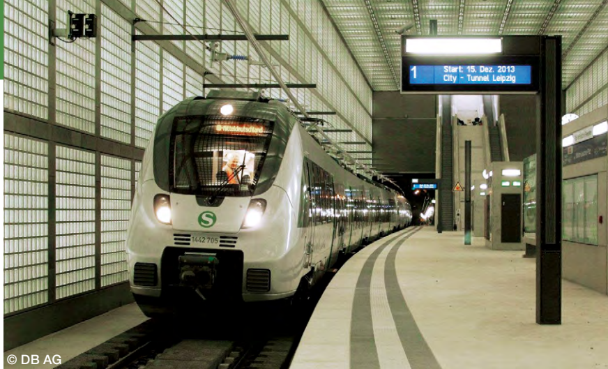
City-Tunnel Leipzig, Station Wilhelm-Leuschner-Platz
